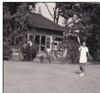
奥の建屋は管理人室
